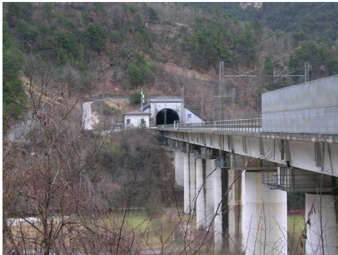
Imbocco Sud – Lato Udine
