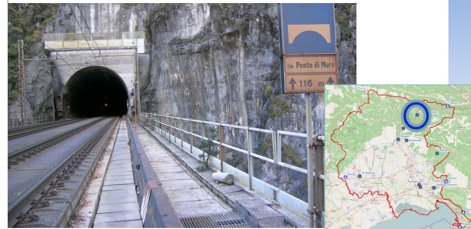
Imbocco Nord – Lato Tarvisio
