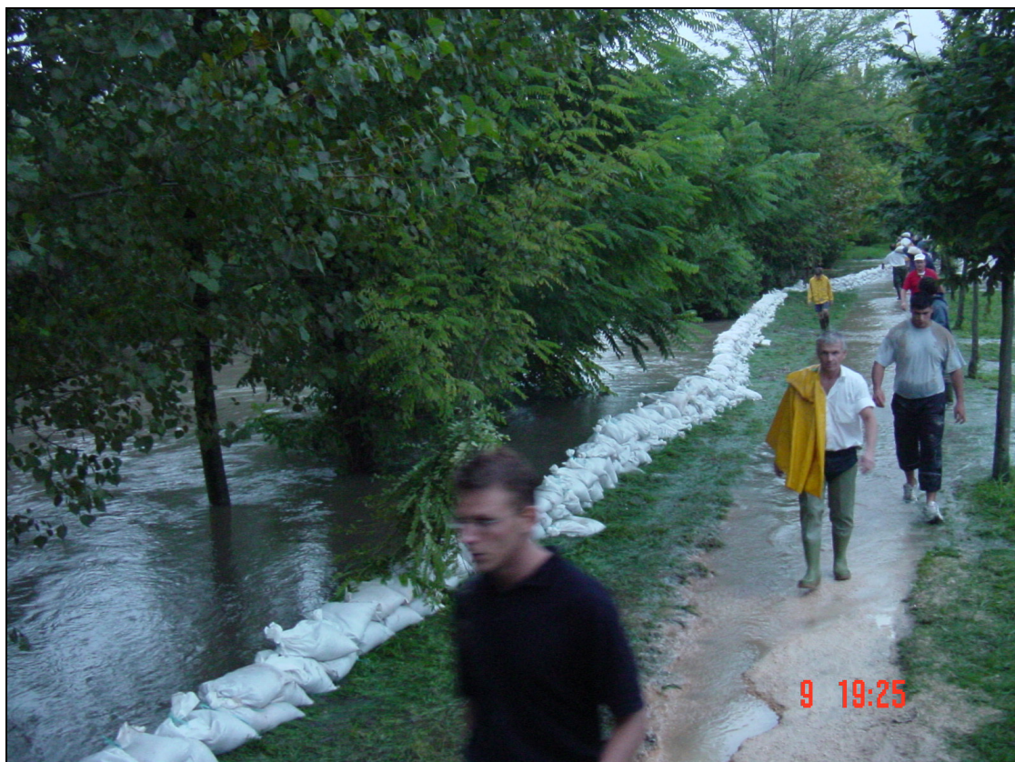
Fiume Veneto: realizzazione di arginello a difesa del capoluogo
