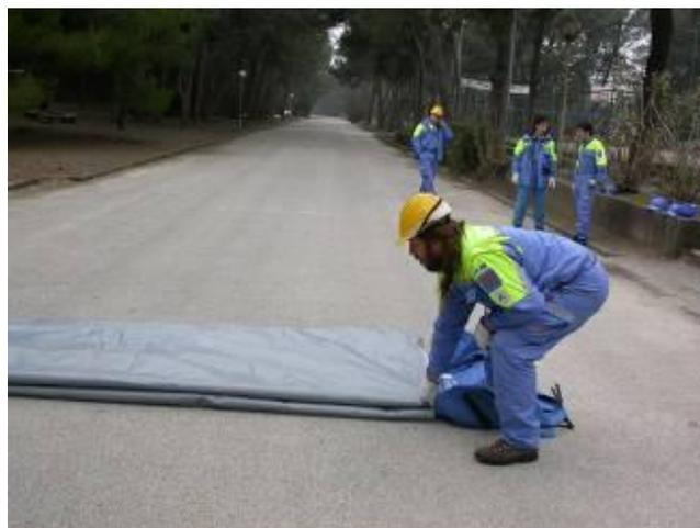
A questo punto arrotolare il telo camera su se stesso per ottenere un diametro di circa 30 cm come in figura e foto.
