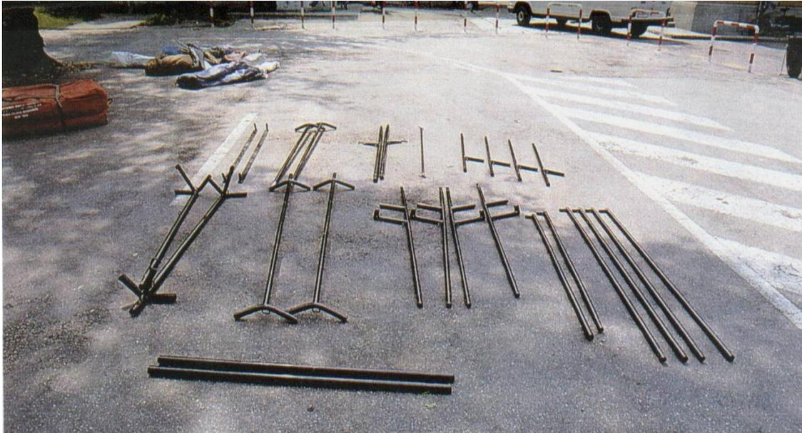
Seguendo lo schema di montaggio si organizza la struttura sul terreno. I quattro pali di diametro maggiore vanno a costituire la crociera centrale del tetto.
