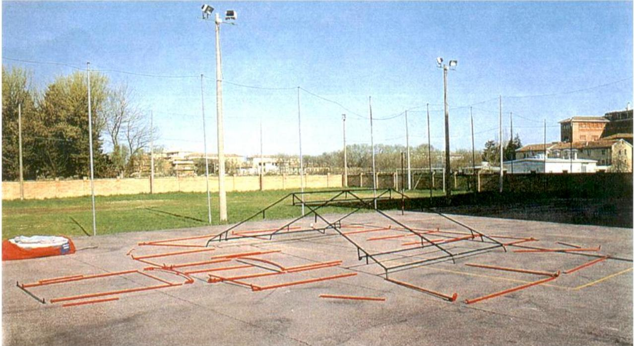
Si procede poi con il posizionamento della camera (telo interno). È a questo punto che risulterebbero particolarmente utili le catenelle (tiranti) indicati precedentemente: se l'intelaiatura del tetto si è allargata, gli ancoraggi della camera non combaciano con gli occhielli, rendendo forzato l'aggancio con il rischio di strappo.
